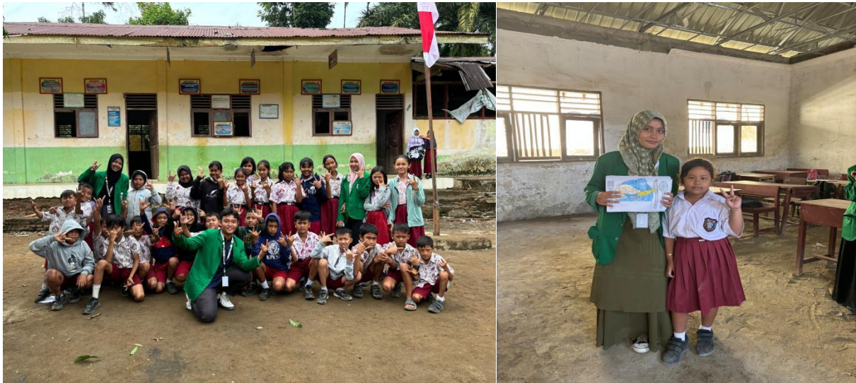
Gambar 1. Kondisi Bangunan Kelas
