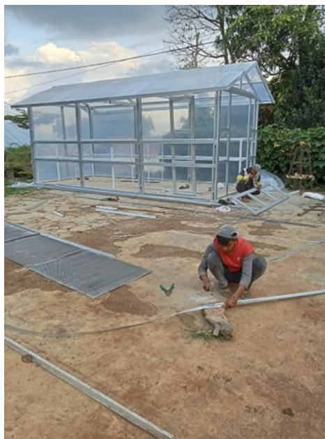
Gambar 1. Proses pembuatan Green house pengering biji kopi.
